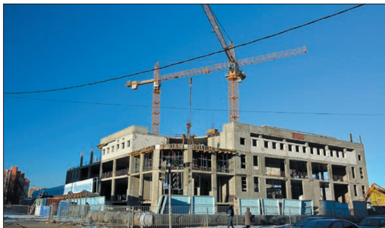
В 2014 году началось строительство первой очереди Дворца спорта
