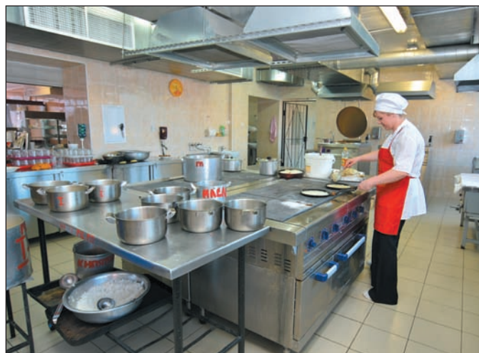
В ИСПЛ N116 проведен капитальный ремонт столовой
