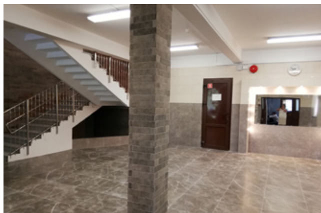
▶ Косметический ремонт холла 1-го этажа в лицее № 378
