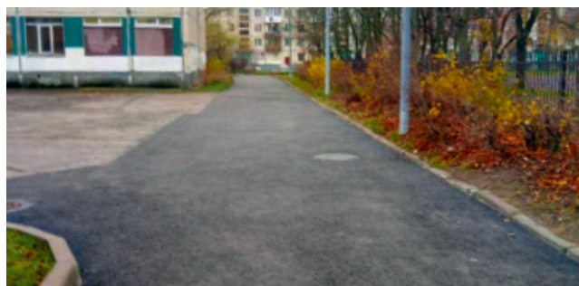
► Замена асфальтового покрытия на территории школы № 383
