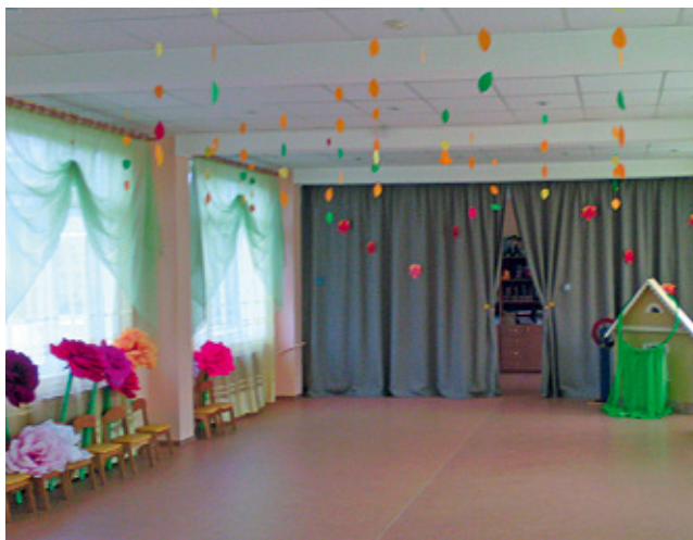
► Ремонт музыкального зала детского сада № 37
