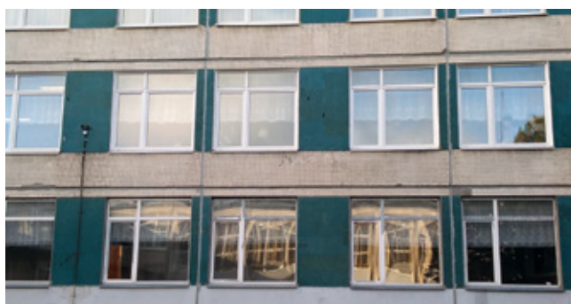
▶ Герметизация швов фасада здания школы № 254
