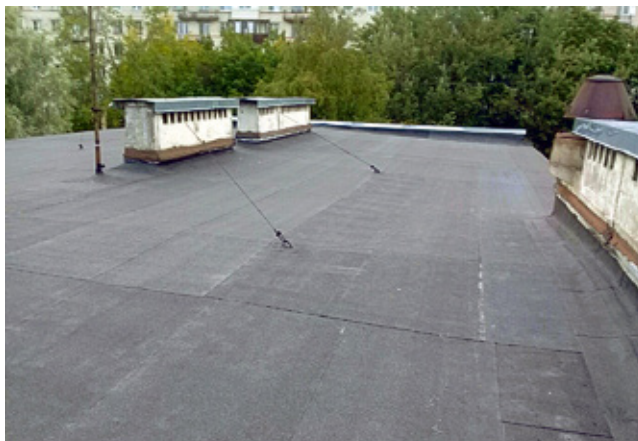
► Частичный ремонт кровли детского сада № 31
