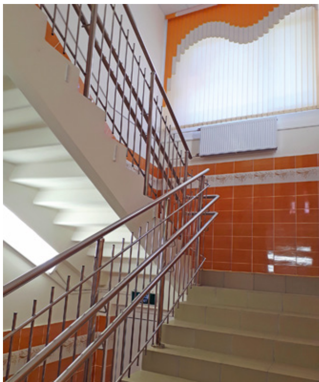
► Ремонт лестничных пролетов в детском саду № 40
