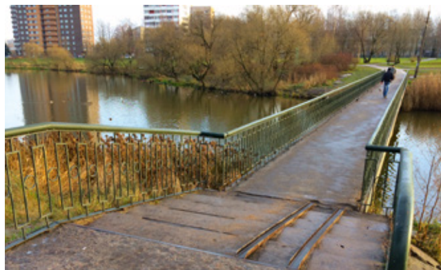
Отремонтированный пешеходный мост через реку Ивановку
