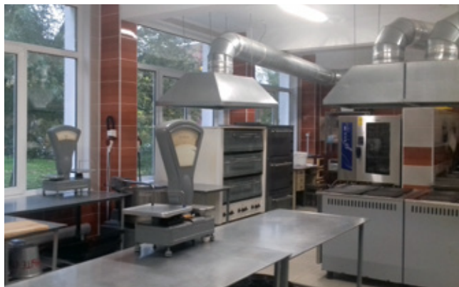
► Ремонт пищеблока в школе № 217
