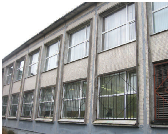
Ремонт и герметизация стыков наружных стеновых панелей здания школы №237
