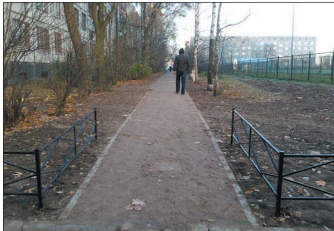
Пешеходная дорожка у дома 187 по пр. Народного Ополчения после ремонта
