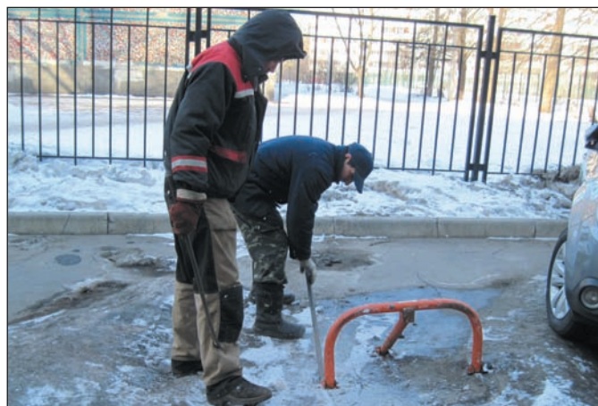
Демонтаж устройства для резервирования места стоянки транспортного средства у д. 14 по ул. Бурцева
