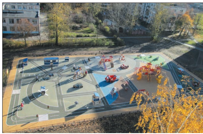
Детская площадка во дворе дома 112 по пр. Ветеранов после реконструкции
