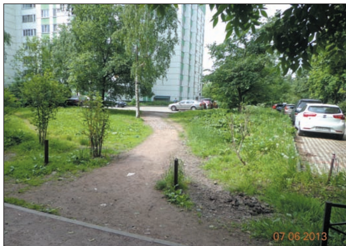
Пешеходная дорожка между домами 11 и 13, корп.2 по ул. Стойкости до ремонта
